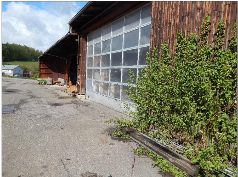
Foto 5: Die Südseite von Ga- rage/Remise.
