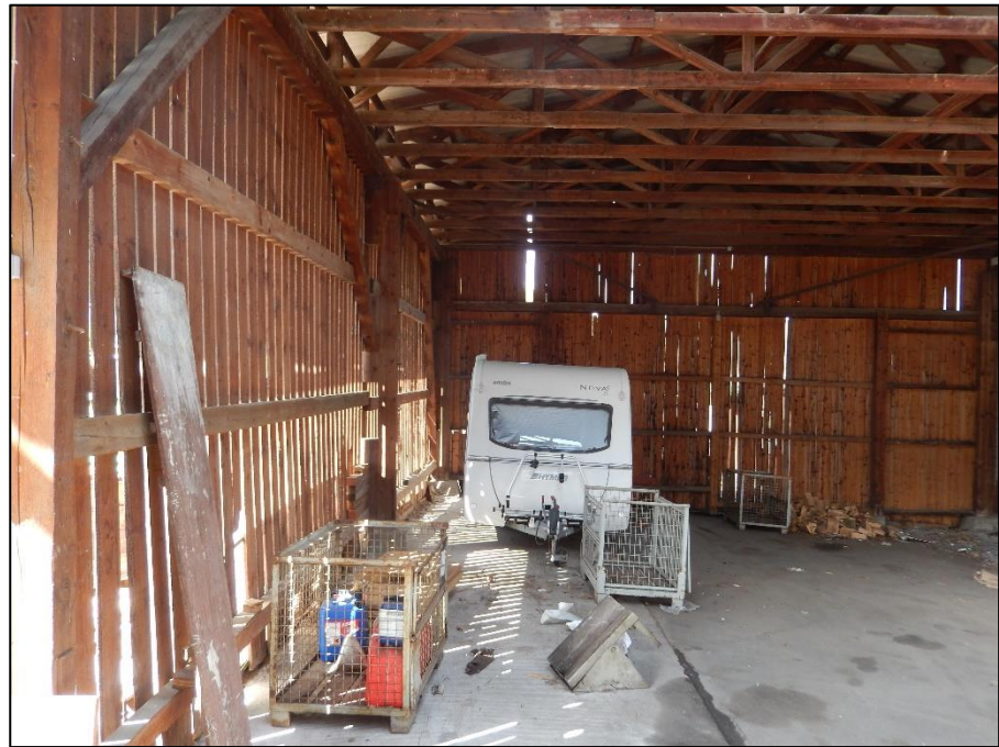
Foto 6: Die Balkenkonstruktion der Remise, aber auch andere Teile der Gebäude, bieten Nistplatzpotenzial für Nischen- und Gebäudebrüter.
